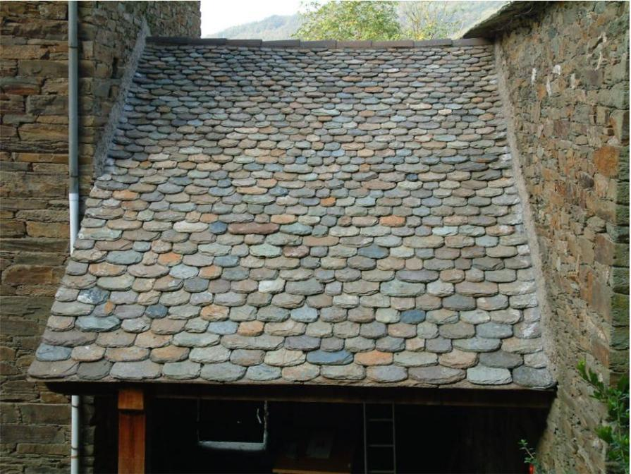
Avant de commencer, le couvreur tri les pierres par largeur, un travail de précision. Puis il commence par le bas, ajustant, mesurant, taillant ses lauzes, jusqu'en haut du toit. Je suis toujours épaté par ces techniques ancestrales : ces murs de 80 cm d'épaisseur, juste tenus par de la terre glaise et leur propre poids. Pas d'engins, pas de grues, juste la force des hommes et des bœufs. Du pur muscle !
